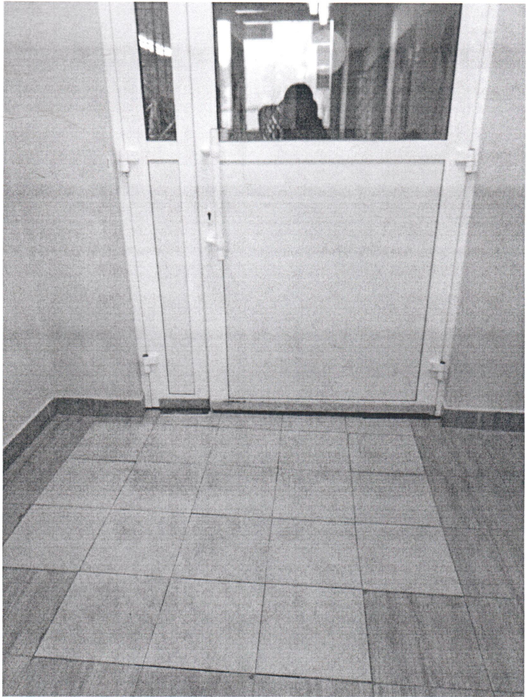
Фото №3. Ремонт плиточного покрытия в тамбуре.
